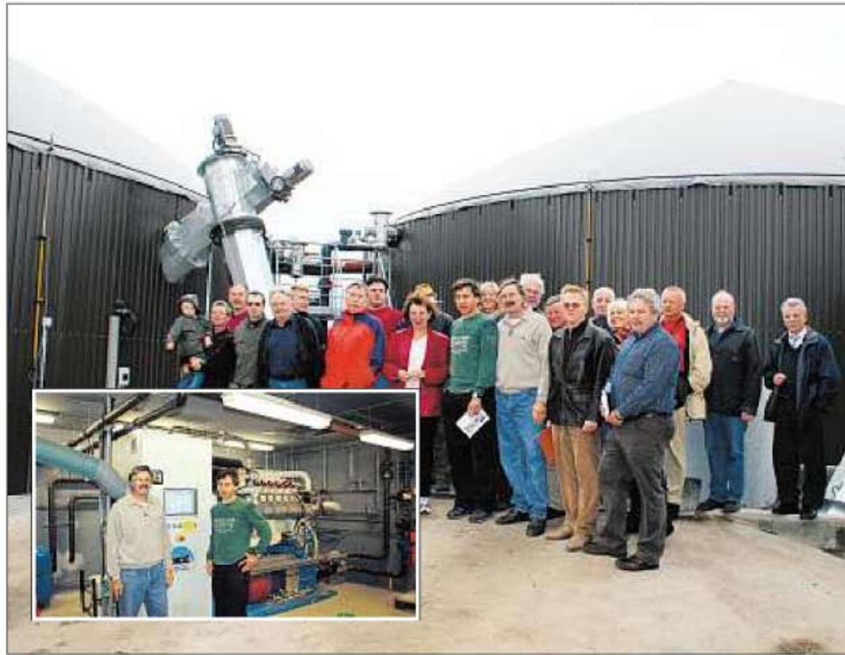
Die SPD-Kreistagsfraktion, der SPD-Arbeitskreis Umwelt und Energie und der Ortsverein Selters besuchten in Münster die modernste und größte Biogasanlage im Kreis. Kleines Bild: Günther Fink (links) und Carlos Merz (rechts) vor dem Herzstück der Anlage – einem Gasmotor. Fotos: Stuart (2)
